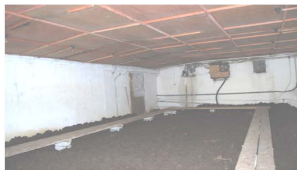
Рис. 1. Переработка органических отходов в закрытой бетонной площадке с системой помостов
