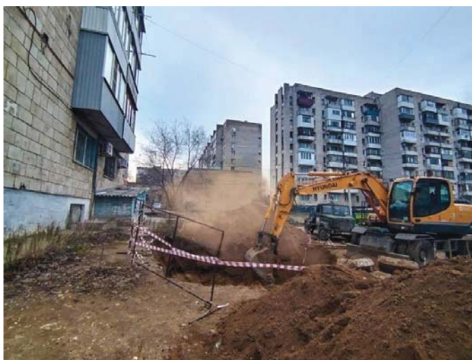
Рисунок 1.6 – Вскрытие аварийного участка трубопровода теплосети на улице им. 51-ой Гвардейской Дивизии в г. Волгограде
