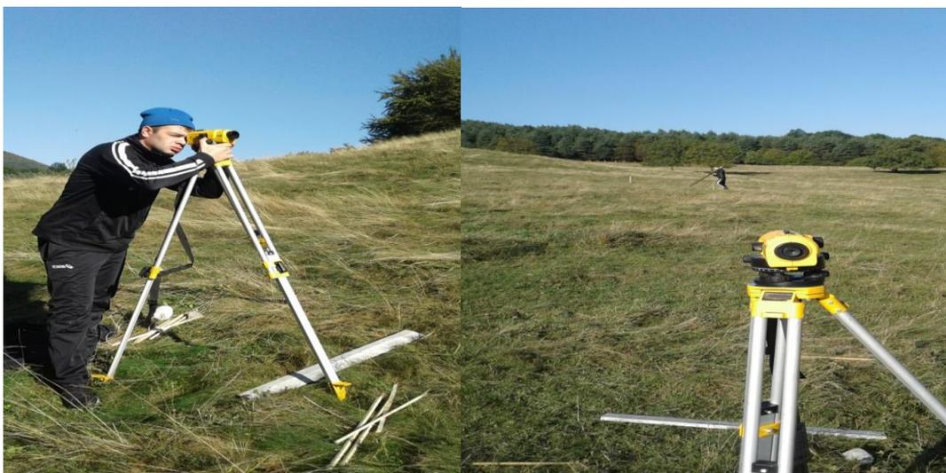
Рисунок 4.5 - Разметка горизонтали склона с использованием нивелира
