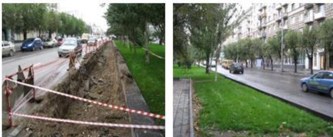
Рисунок 6 - Панорама производственных процессов дорожно-строительных работ по уширению проезжей части по периметру бульвара пр. В.И. Ленина
