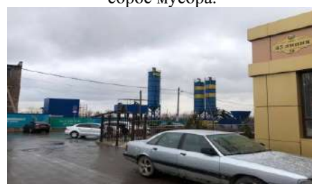
Экологический риск E4. Пылевое загрязнение из-за неправильного размещения бетоноузла
