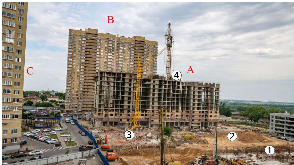
Рисунок 2.3 – Схема расположения контрольных точек отбора проб частиц пыли на строительной площадке в летний и зимний периоды.
