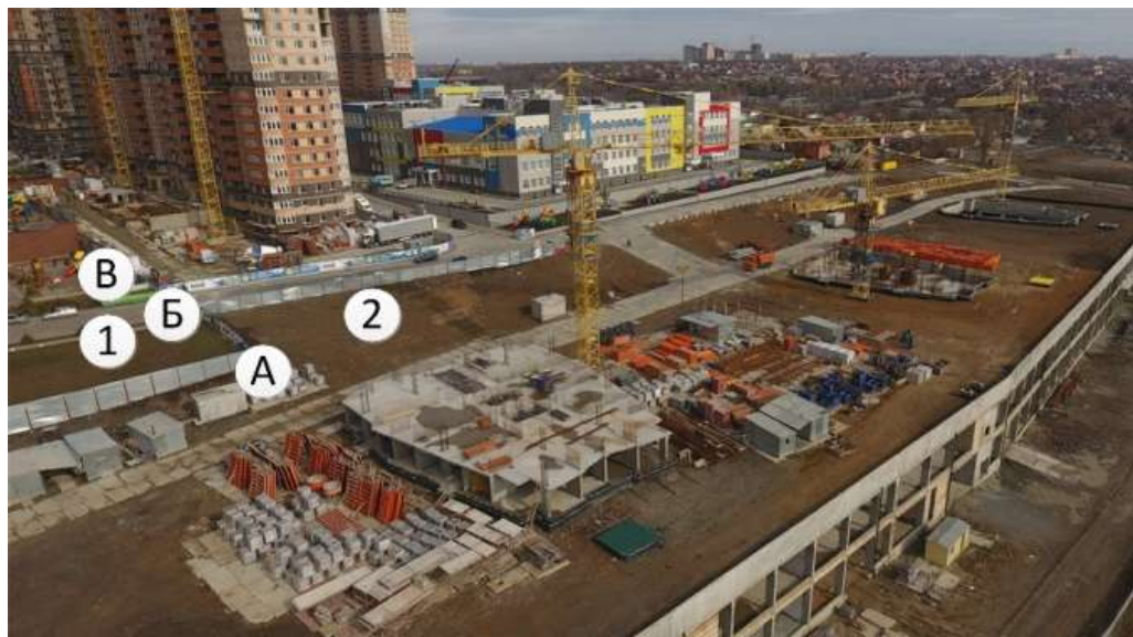
Рисунок 4.14 – Строительная площадке точечной застройки: 1, 2 – места высадки растений; А, Б, В – контрольные точки измерения концентрации РМ10
