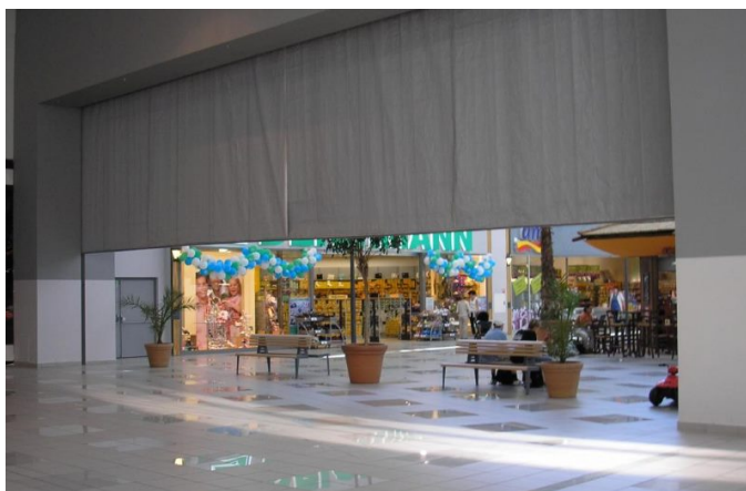
Рисунок 1.8 – Пример использования фасадных огнестойких штор
