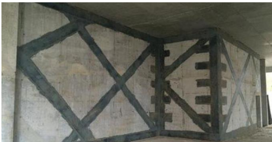
Рисунок 1 – Пример применения углеволокна для усиления конструкций
