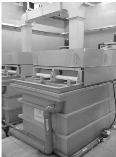
Рис. 3. Очистные сооружения цеха нанесения гальванических покрытий, реализованные сотрудниками РХТУ им. Д.И.
