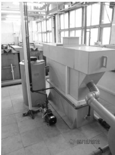
Рис. 2. Очистные сооружения цеха нанесения гальванических покрытий, реализованные сотрудниками РХТУ им. Д.И.
