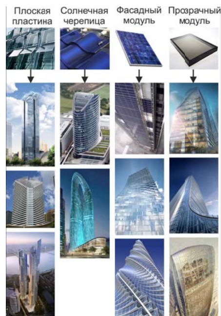
Рис. 4. Виды интегрируемых строительных фотоэлектрических модулей
