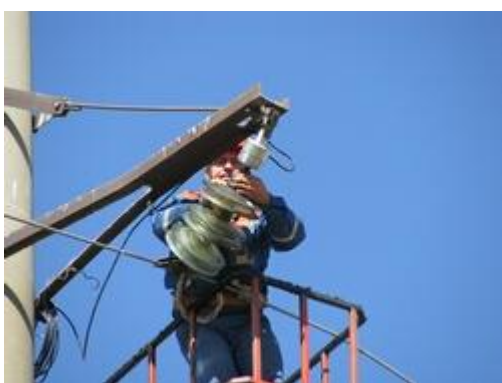
Рис. 2. Монтаж тензометрического датчика в месте подвеса фазного провода
