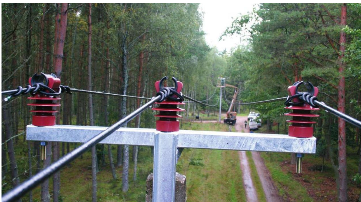
Рис. 1. Монтаж ВЛЗ 10 кВ с проводом СИП-3
