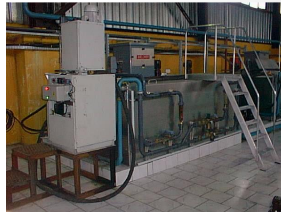
Обезвоживание осадка промышленных стоков, полученного с помощью катионных полиэлектролитов на ленточном пресс-фильтре Belmer
