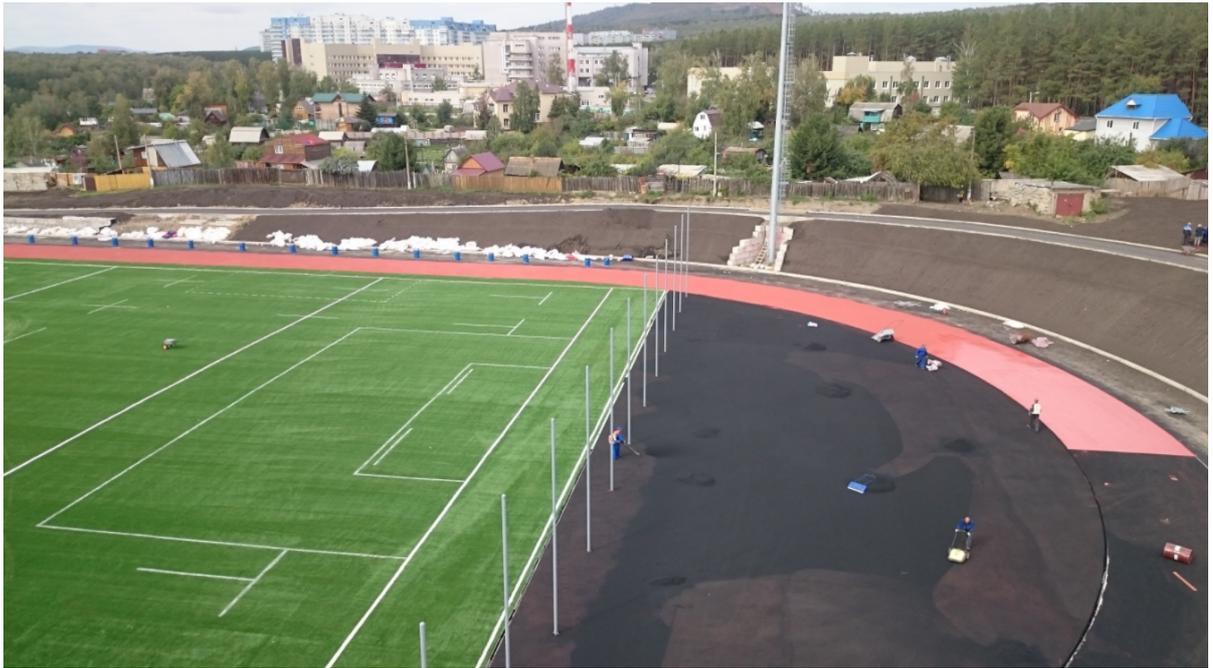
Рисунок 6.3 – Процесс укладки покрытия с улучшенными низкотемпературными свойствами на легкоатлетическом стадионе Сибирского федерального университета, г. Красноярск
